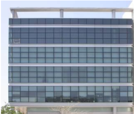
כמעט כל החלונות בחזית הצפונית בבניין משרדים זה חסומים על ידי צלונים פנימיים
